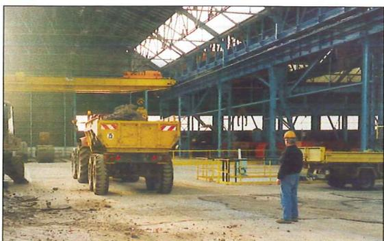
Désormais, les aiguilles métalliques ont remplacé le bon vieux treillis soudé. Ainsi, le sol plus élastique, permet de pallier aux fissures importantes occasionnées par l'ancien revêtement. SLPM étant un Centre de Service, La halle E avec un sol tout neuf peut maintenant servir de plate-forme logistique !
